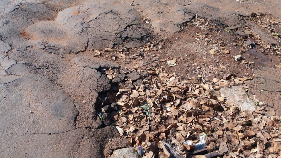
Rua 25 de Julho, fotos:
